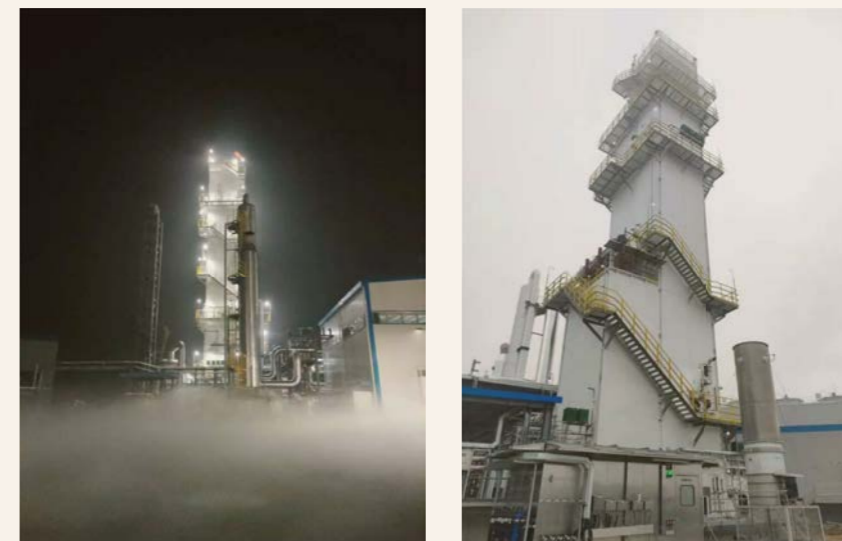
◀ 青岛杭氧高纯氧项目最终调试
