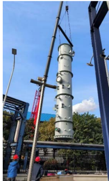
萧山杭氧顺利完成年度大检修
